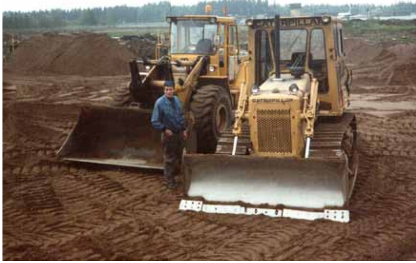
Ahti, Caterpillar D4E ja Volvo 846 Pirkkalan lentokentän laajennustyömaalla. Vuosi on ehkä 1988.
