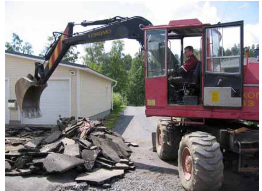
Timo kaapii asfalttia Lokomolla Ukinrannassa.
