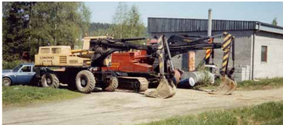
Lokomot uuden huoltohallin edessä. Ahti Virtanen rakensi hallia vuosina 1975 ja -76. Rakennustyöt oli kustannusten säästämiseksi tehtävä mahdollisimman paljon itse. Siksi esimerkiksi ovet hän valmisti yhdessä veljensä kanssa paikan päällä.
