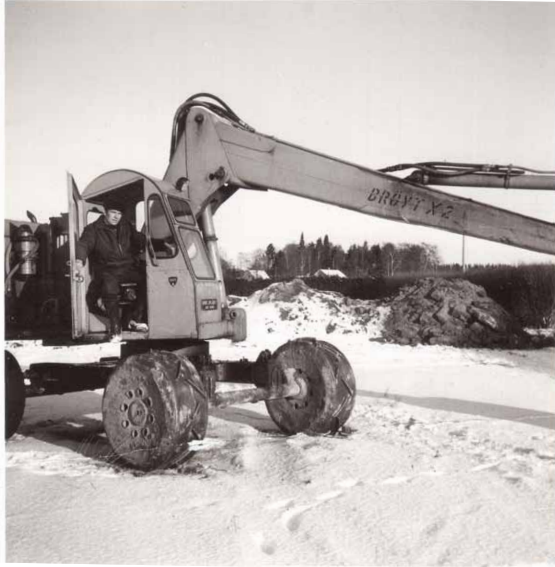
Ahti Virtanen vasta hiljattain hankkimansa Brøyt-kaivinkoneen kyydissä. Brøyt X2 tuli Ahti Virtaselle käytettynä 60-70 -lukujen vaihteessa. Kone oli ostettaessa luultavasti alle viiden vuoden ikäinen. Tämä kone oli Virtasen ensimmäinen varsinainen ympäripyörivä kaivinkone.
